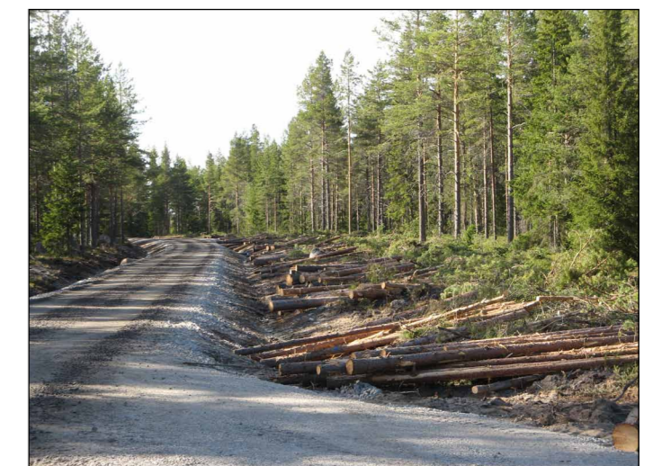
Förberedande avverkning inför kabelförläggning i mark längs vägen på Bondön. (foto: Kerstin Boström, ÅF)
