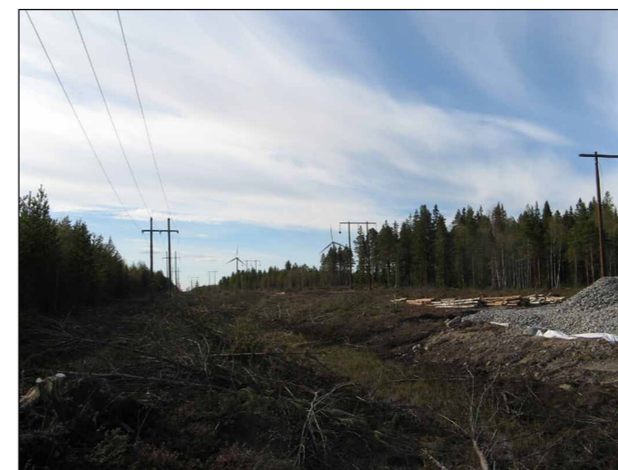
Breddning av kraftledningsgata på Pitholmen inför anslutningen av vindkraftverken på Bondön 2008. (foto: Kerstin Boström, ÅF)
